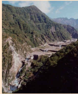
国の重要文化財に指定（H21.6） されている 白岩砂防えん堤（富山県）（左）
