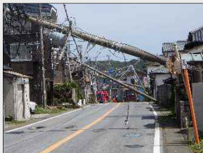
< 令和元年台風 15 号による被害 >
