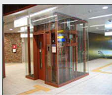
鉄道駅等における段差解消
