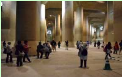
首都圏外郭放水路 (埼玉県春日部市)
