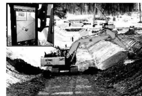
ICT建設機械による施工
