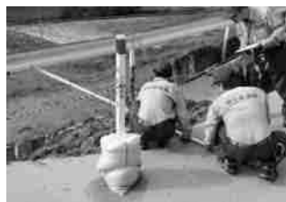
被災状況調査 (福島県二本松市)
