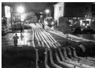
内水排除作業 (福島県郡山市)
