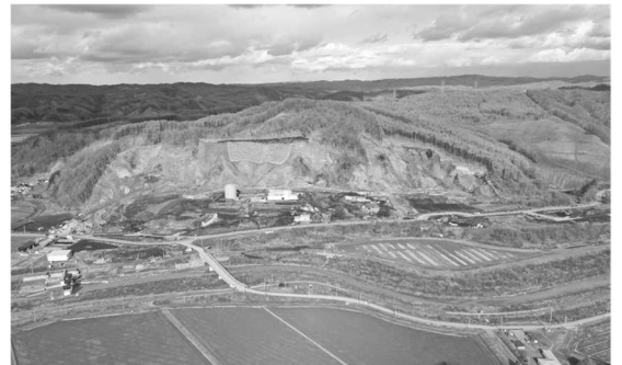
残留土塊除去作業が完了し、現在は法面対策工事等を実施中
