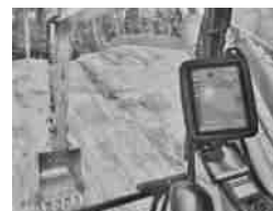
3次元データを活用した作業状況
