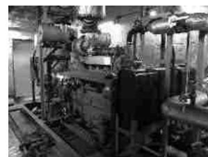
非常用電源装置のイメージ
