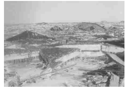
流水等により破壊された家屋 （昭和27年 十勝沖地震） 資料提供：浜中町役場
