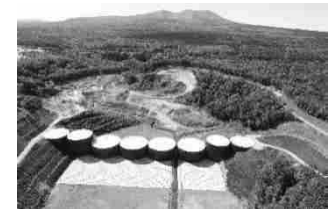
樽前山覚生川2号砂防堰堤（苫小牧市）
