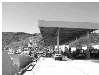
屋根付き岸壁
