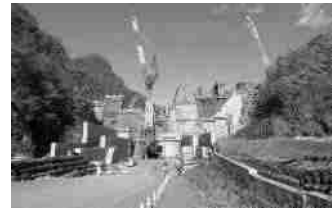
工事中の平取ダム（平取町）
