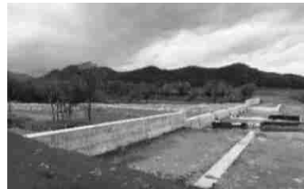
十勝川水系戸高別川第2号砂防堰堤（帯広市）
