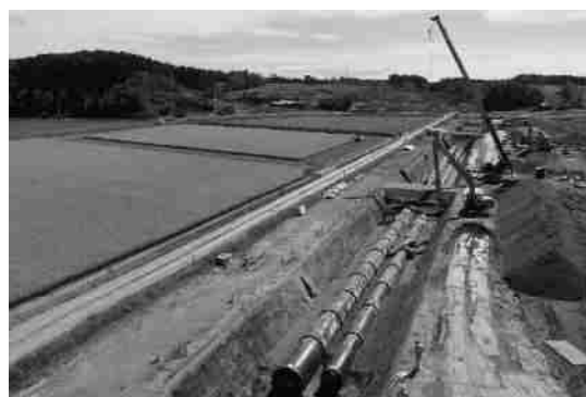
農業用水路の復旧状況
