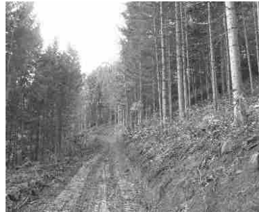
路網（森林作業道※ 2 ）の整備
