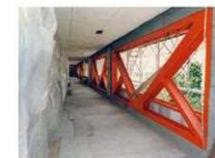
鉄骨ブレースによる壁の補強
