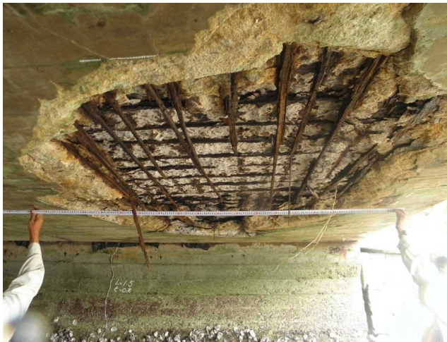
地方自治体管理 床版鉄筋露出
