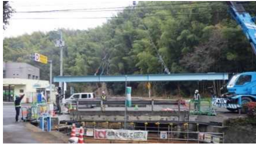
クレーンで主桁を撤去して支承を補修 主桁は工場で補修し再架設
