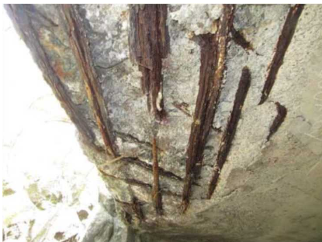
国管理 床版鉄筋露出 ※床版: 橋の裏側
