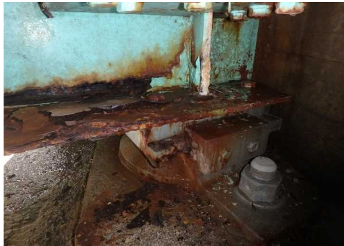
地方自治体管理 主桁腐食
