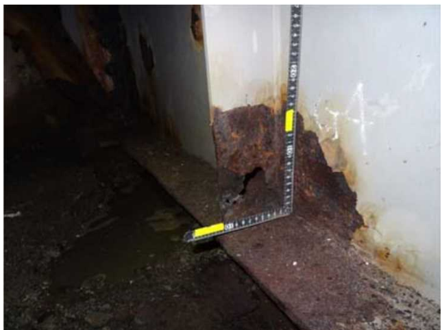
国管理 主桁腐食・欠損
