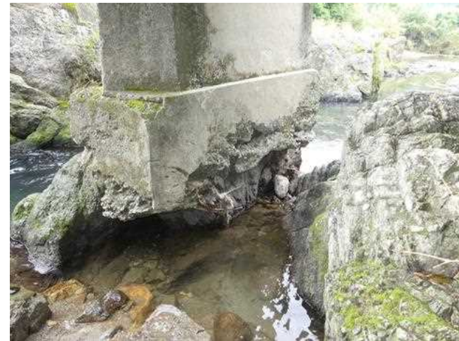
地方自治体管理 橋脚洗掘
