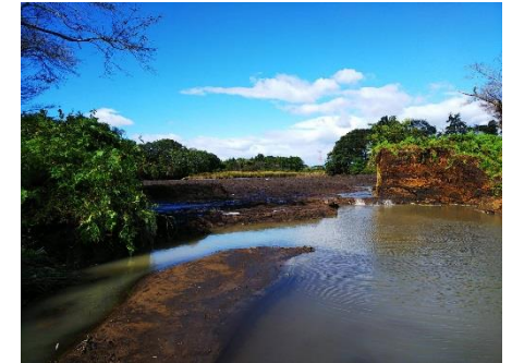
ため池の被災状況(決壊)※
