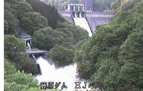
平成24年5月 放流の様子(藤原ダム)
