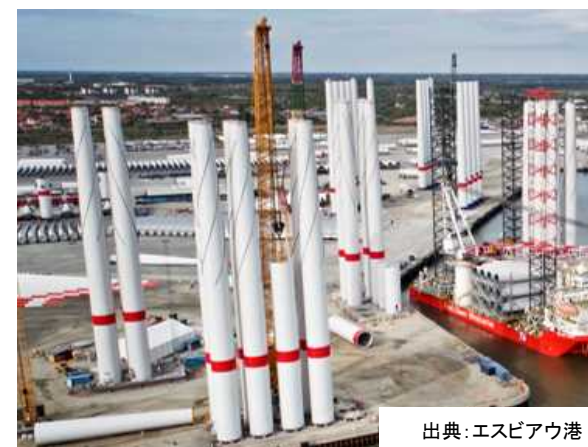
2. タワー組み立ての様子
