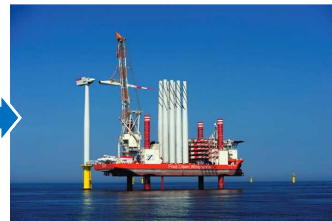
5. 洋上工事の様子
