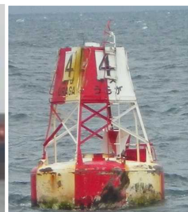
浦賀水道航路中央第四号灯浮標 (灯器、太陽電池パネル等損壊)
