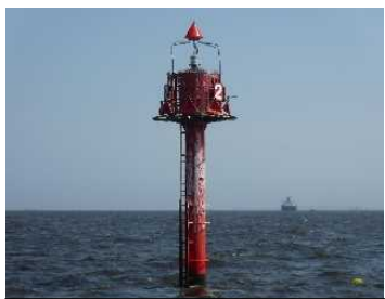
船舶接触事故前 (横浜航路第2号灯標)
