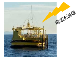
AIS信号所が設置されているシーバース（京浜川崎シーバースの例）
