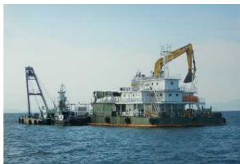
トレミー船による窪地への土砂投入
