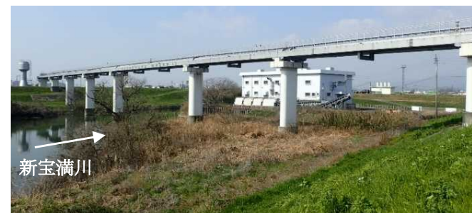
思案橋水管橋
