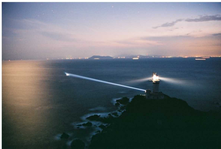
【(図表㉑)照射灯への高輝度 LED 導入例】〔出典：海上保安庁〕
