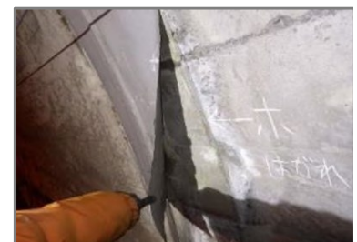
(a) はく落対策工※背面からの漏水によりシートがはく離
