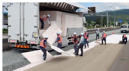
写真-1 断熱材の施工状況
