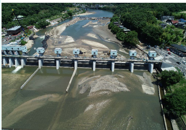
写真-1 明治頭首工漏水事故 堰上流水位低下 （中部地方整備局提供）
