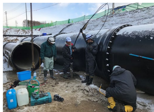
写真-2 管水路への沈下計の設置状況
