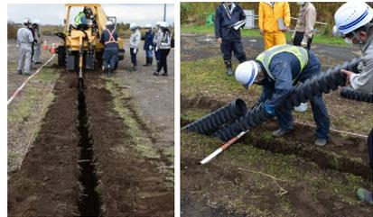
トレンチャーによる細溝掘削断面の管路敷設試験
