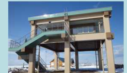
積雪寒冷を考慮した防寒機能付の津波避難タワーの整備
