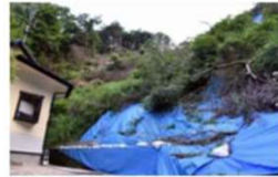
豪雨の度に土砂崩れが多発
