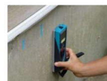
基礎配筋の調査
