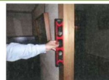
水平器による柱の傾きの計測
