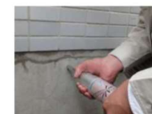
リバウンドハンマーを用いたコンクリートの圧縮強度の測定
