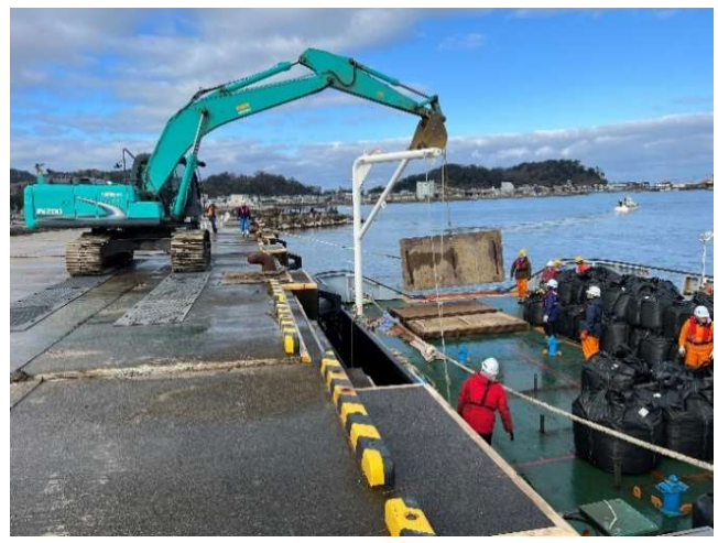
新世丸(日本埋立浚渫協会) (1月14日)@輪島港
