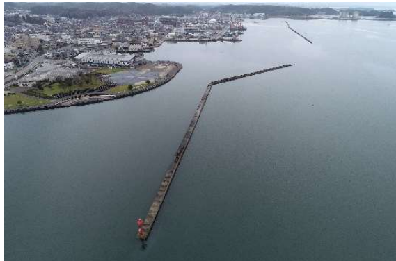
七尾港の被災状況調査(1/3)
