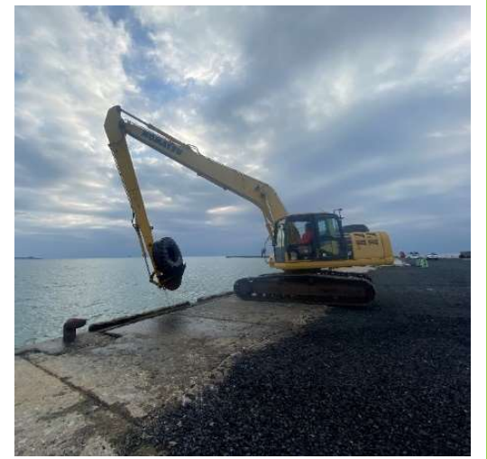
石材撤去作業の実施状況 (1/19)
