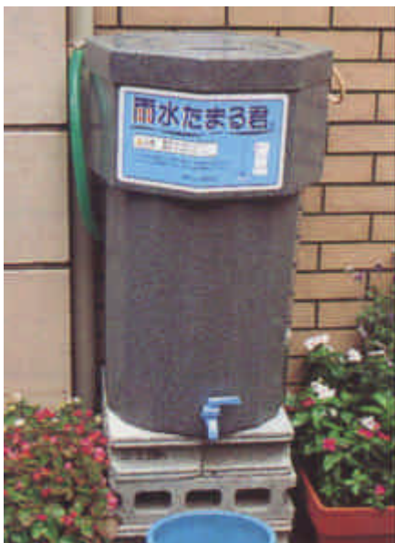
図 雨水貯留槽
