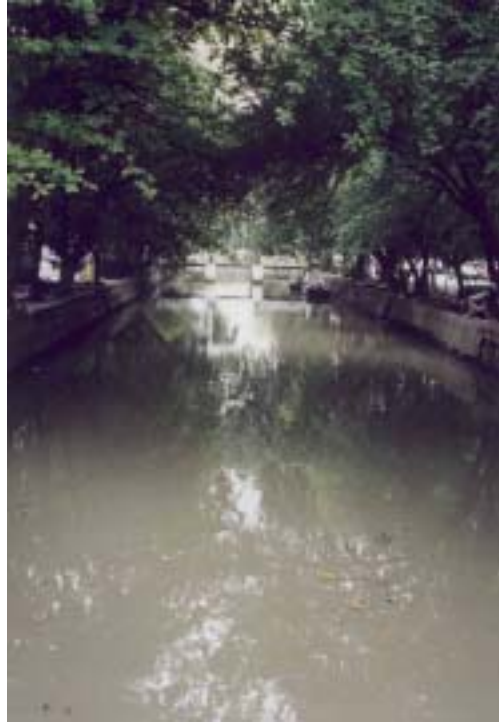
写真24 ロート水路(バンコク)
