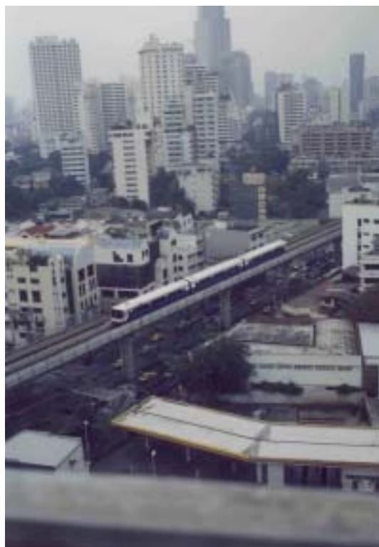
ビルの間を走る高架の新交通システム。幹線道路の上である。
