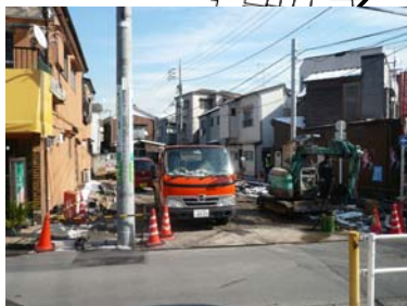
最近建物が除却され、空地になった場所。道路の拡幅工事が行われている
