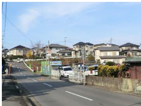
図表 3-3-1-2-3 地区の外周部から地区を見上げた様子
