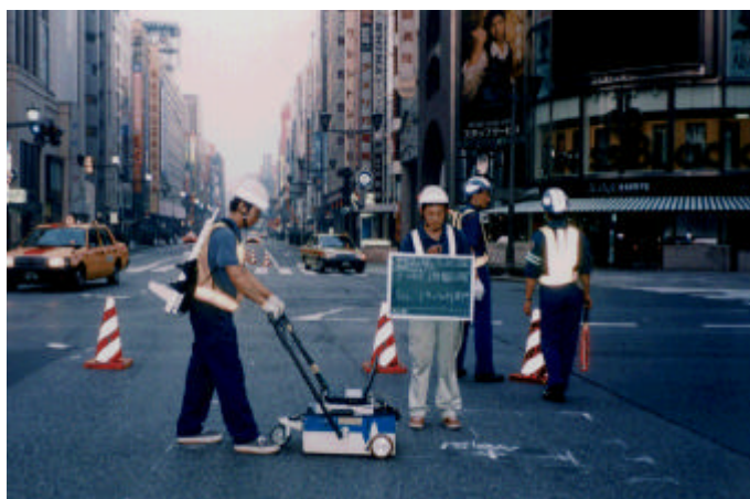
路面下空洞調査作業時
