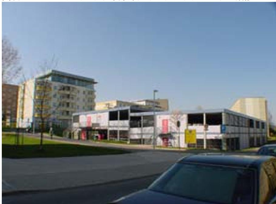
手前には1棟を撤去してガレージに建て替えている。左手奥の6階建ての建物は左右約3分の1を撤去して、屋上にガラスのペントハウスをもうけ、各階には円弧形のテラスを取り付けた。この建物の大家は撤去には消極的で、かつ住人達もこの建物に残ることを希望した結果、このような形の改修が行われた。
