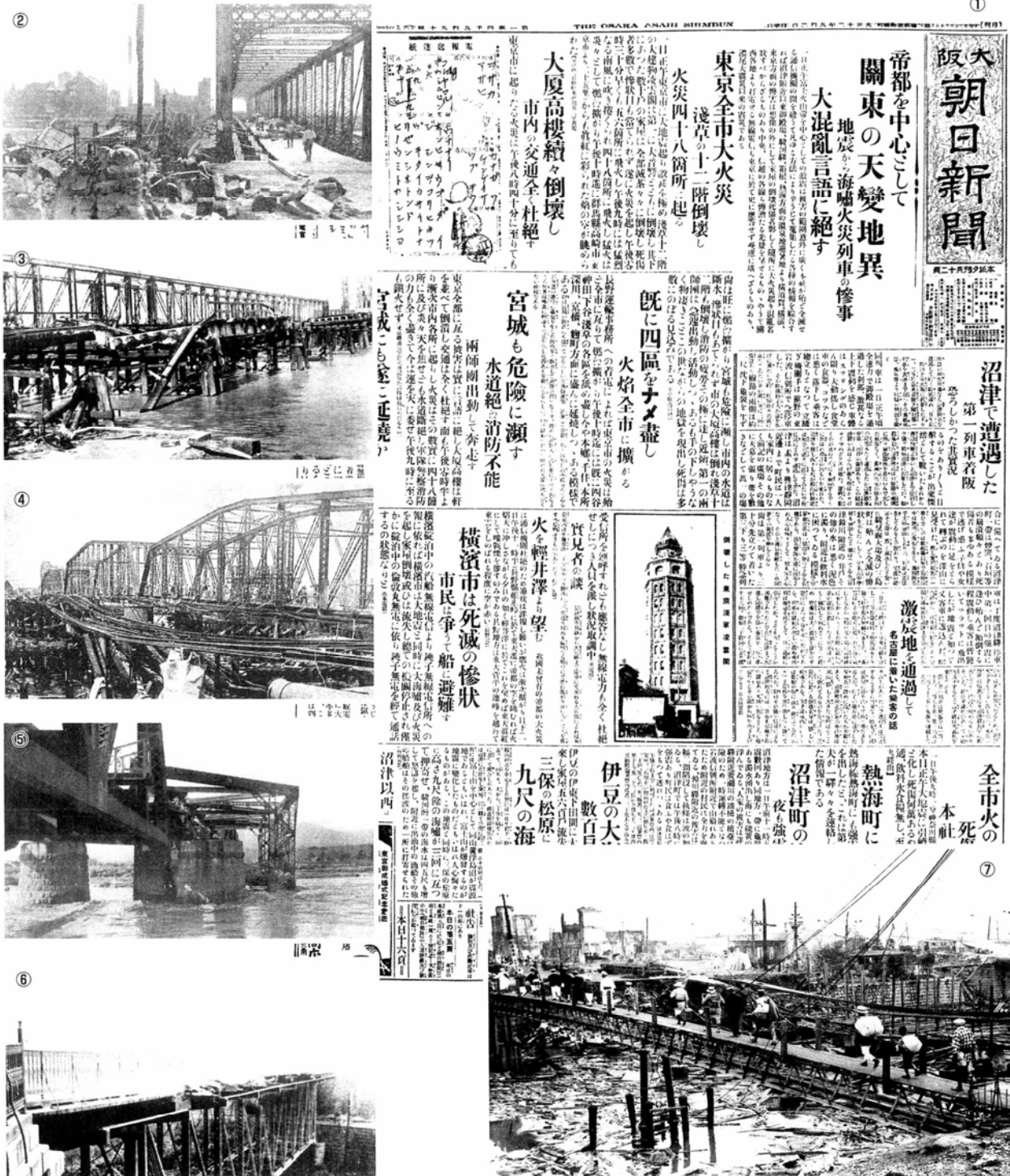
①関東大震災を報ずる翌日の大阪朝日新聞。 ②木製の床版が燃えおちたので、臨時に角材を張りわたし、応急措置を行っている。吾妻橋。[写真：土木学会提供] ③破壊された電車専用橋。 ④永代橋の床版が焼けおちたため、対岸に逃げるのができず、多数の犠牲者を出した。[写真：土木学会提供] ⑤墜落した横浜の酒匂川鉄橋。[写真：土木学会提供] ⑥炎上中の御茶ノ水橋の木床版。 ⑦神田橋付近の仮橋を渡る市民。
