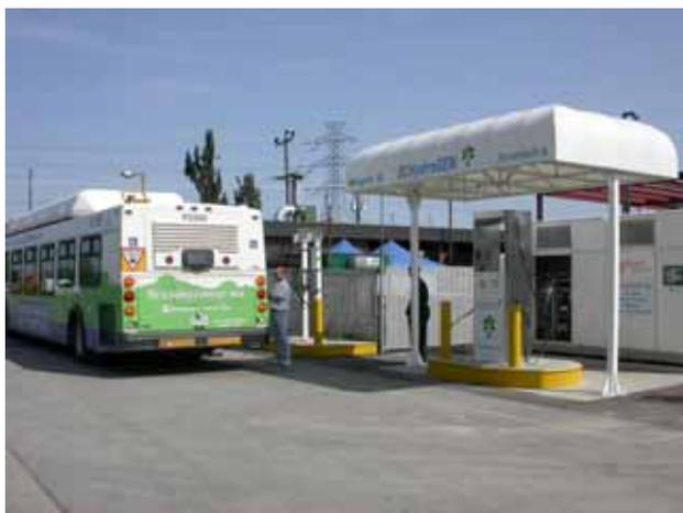
図 3-15 Westport の PowerTech の 700bar 水素供給ステーション
