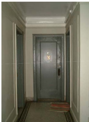
部屋の床の傾きもかなりあったが廊下からゆがんでいる
