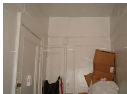
数戸を1戸にリフォームしたらしく、ペンキで上から塗りつぶされたドアの後がある
