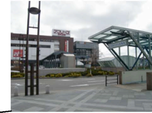
弘前駅と商業施設
