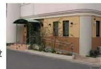
商店入口の段差の解消の例
