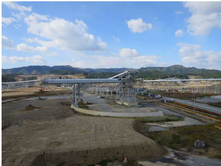
写真 2 平成 26 年 11 月 陸前高田市
