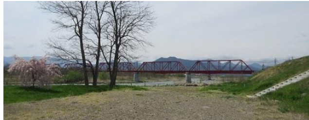
写真10 千曲川河川敷(2017年4月撮影)
