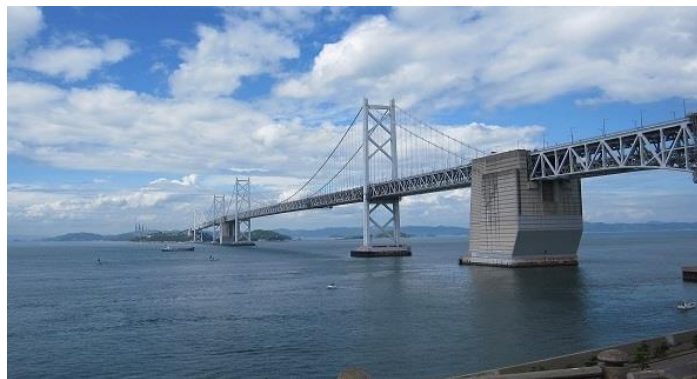
写真2 瀬戸大橋記念館展望スペースから見た南北備讃瀬戸大橋(2012年8月撮影)
