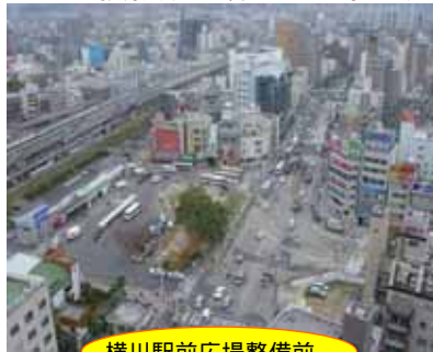
横川駅前広場整備前
