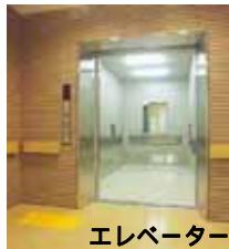
エレベーター
