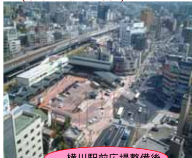
横川駅前広場整備後
