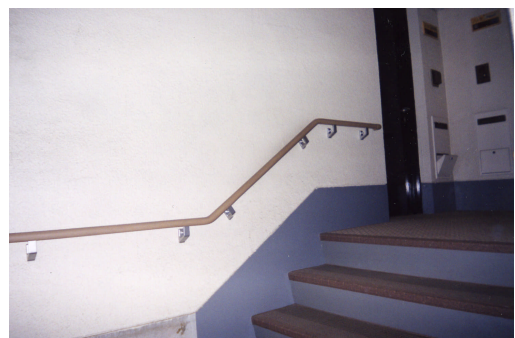
共用階段への手すり設置
