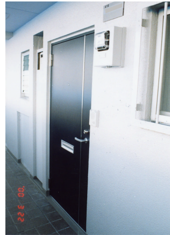
住戸ドアの性能のグレードアップ（プレストアからフラッシュドアへの取替え）
