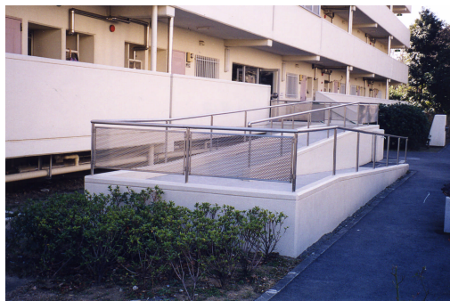
1階共用外廊下へのスロープ設置
