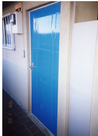
住戸ドアの性能のグレードアップ（プレストアからフラッシュドアへの取替え）
