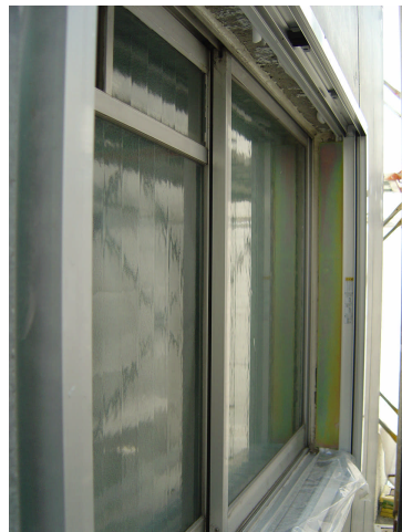
外付け工法による窓サッシの2重化
