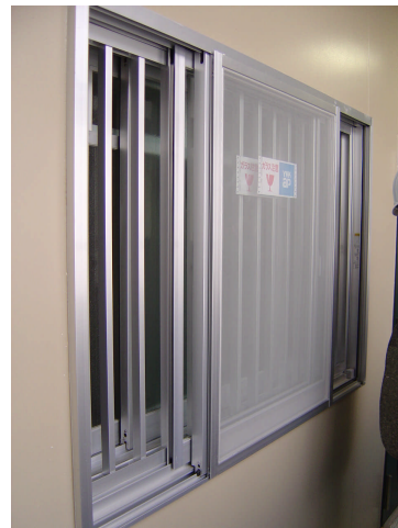
非常時脱出機能付き面格子の設置
