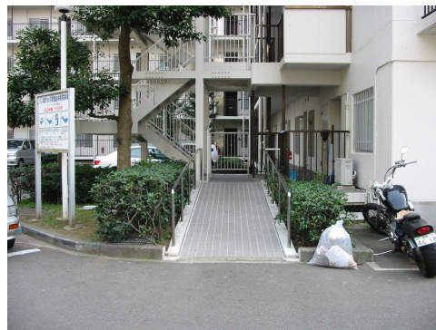
取替え後の屋外鉄骨階段と階段へのスロープ設置
