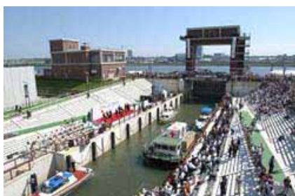
写真 3.2 荒川ロックゲート
