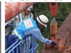
ケーブルの力バー部の腐食
