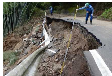
国道349号 路肩流出
