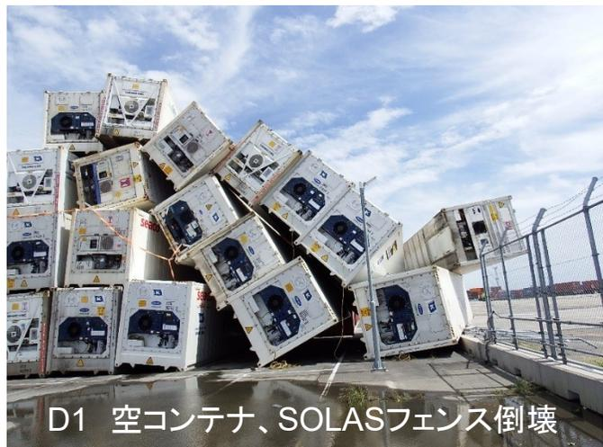
D1 空コンテナ、SOLASフェンス倒壊
