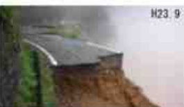
【写真】国道168号崩壊状況
