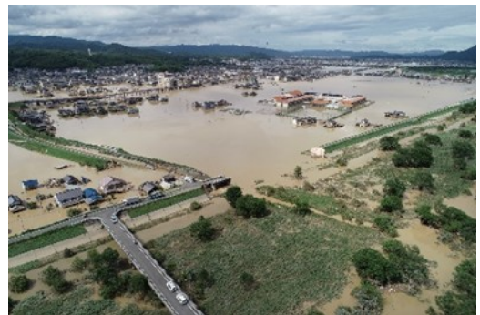
堤防決壊状況 ( たかはし 高梁川水系 おだ 小田川)
