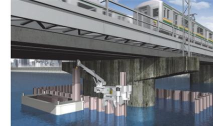
橋梁桁下での橋脚補強工事
