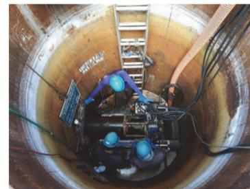
液状化対策工事（GM 推進工）
