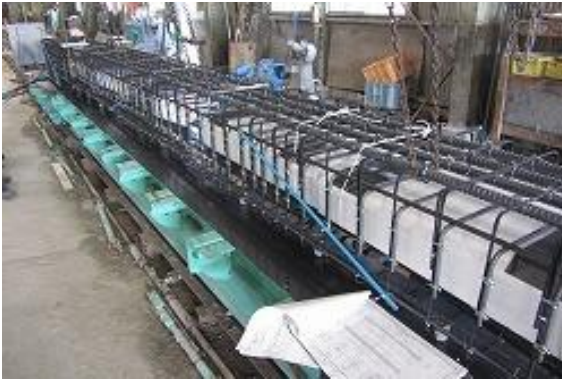
補強材組立状況
