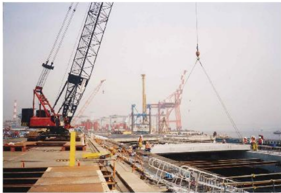
PCホロー桁架設状況
