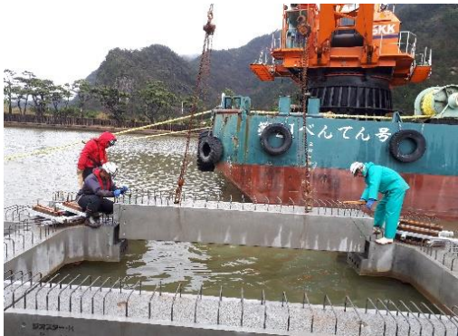
梁部材の据付・連結
