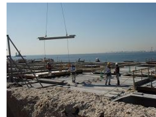
架設状況写真(1)
