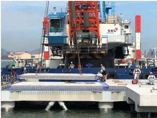
国土交通省施工実績写真 水島港
