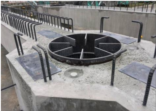
杭との接続部
