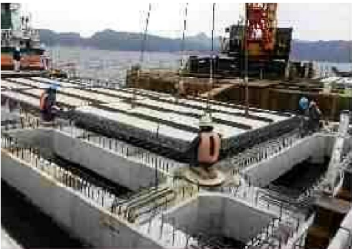
床版部材の据付
