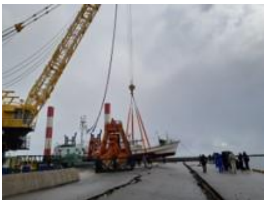
飯田港における啓開作業（小型船の引き上げ） <2月27日撮影>
