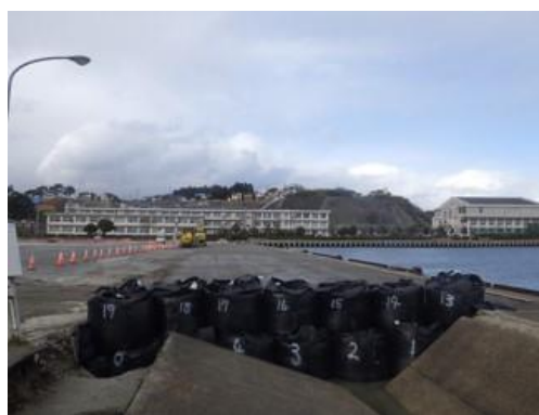
宇出津港における応急復旧（岸壁の段差解消） <3月4日撮影>
