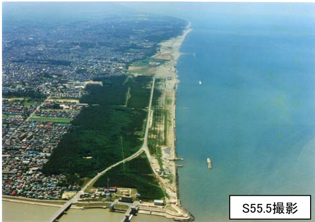
整備着手直後の侵食状況
