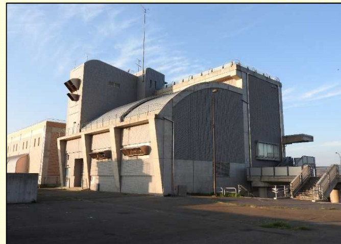
鳥屋野潟排水機場
