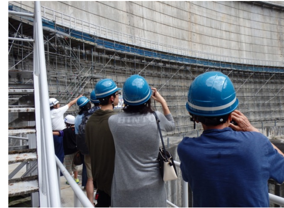
ダム下流面状況 (8月13日)
