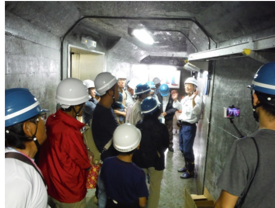
ダム堤体内状況 (8月20日)
