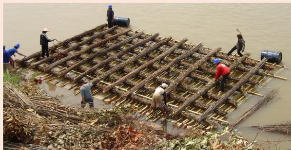
図3-5 粗朶沈床工法
