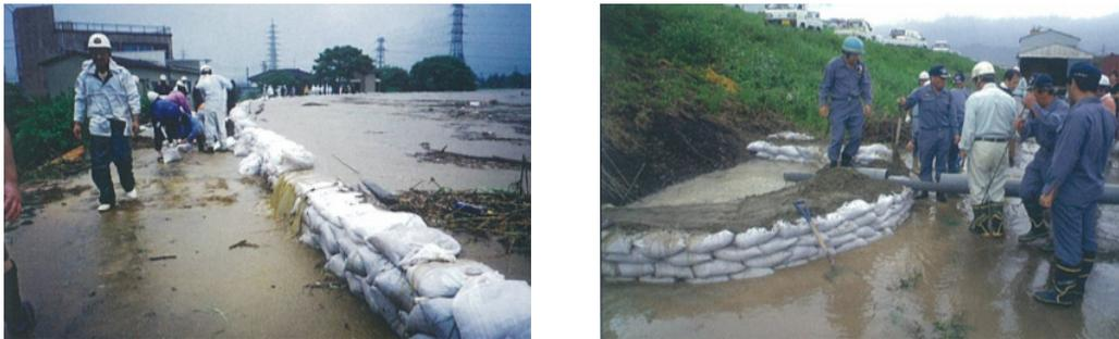
図3-13 水防団による水防工法の実施
