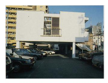
▲鶴見川の近くに住んでいるため過去の経験を生かし、洪水時に被害がないようピロティ構造とした
