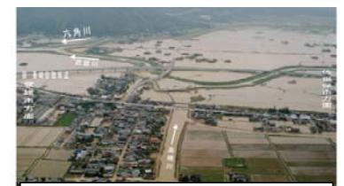
H2.7洪水 R34の冠水状況 堤防と規格の高い道路は冠水を免れる
