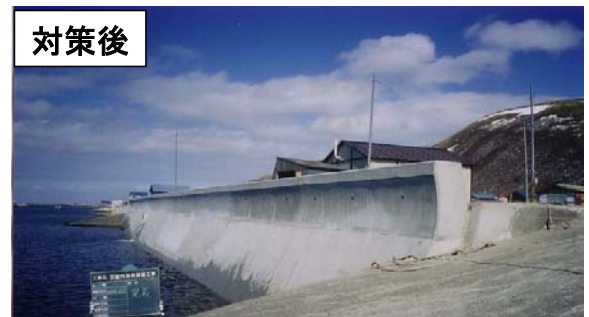
前腹付けによる老朽化対策後の護岸
