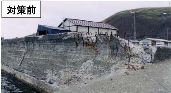
コンクリートの劣化等老朽化が進んだ護岸
