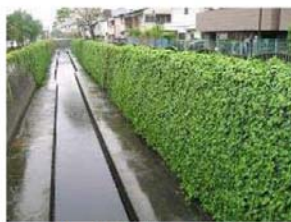
ツタによる護岸の緑化
