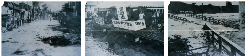
岡山市内の浸水の様子
