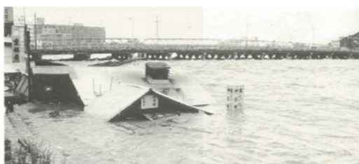
昭和47年7月洪水の状況(京橋地区)
