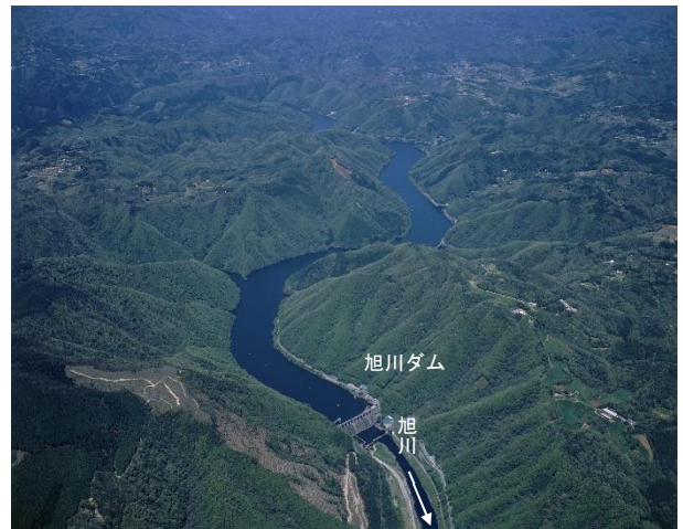
旭川ダム及び貯水池を望む
