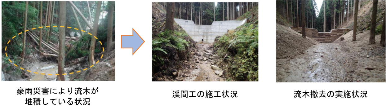
図-4.3.8 国有林保全施設(治山)の整備の取り組み例(令和2年度(2020年度) 深谷溪間工事)
