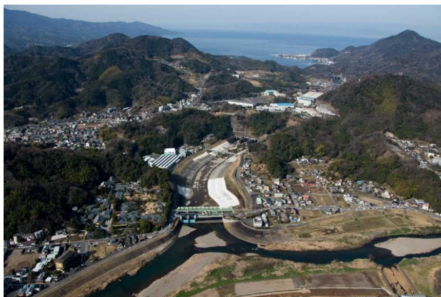
狩野川放水路
