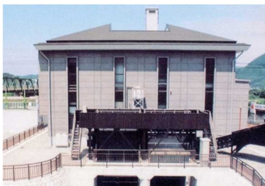
四日町排水機場
